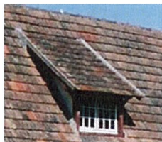
Lucarnes rampantes (chien couché)
