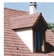
Lucarne à deux pans en bâtière sans rebord en façade
